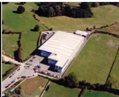
Instalaciones Ferqui año 1991.
